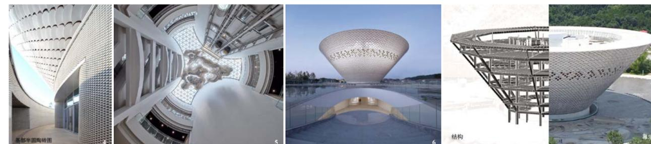
节点，实现了“强节点、弱构件”的设计思路。层间小柱的创新性设计，有效缩减上一层梁的跨度，且使传力路径更加直接。
